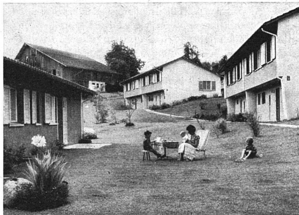
Fig. 2 Einfamilienhäuser der Baugenossenschaft «Krummbächli», Richterswil
