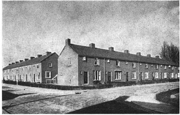
Hoek van de Rovaartstraat, erbaut 1953
