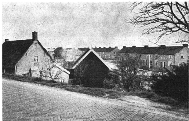
Es sieht aus, als ob sich die alten Häuser hinter den Deich mit der Verkehrsstraße ducken würden, um sich gegen den Wind zu schützen
