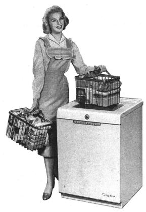
Tiefkühltruhe City-Box ELEKTROLUX (Absorptionssystem)
