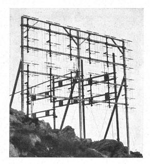
Antennenanlage für Auslandübertragungen Cliché Medialux AG
