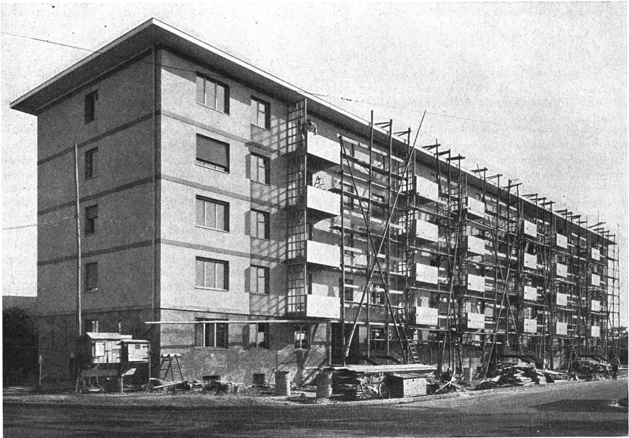
Gesamtansicht der Bauten kurz vor der Vollendung
