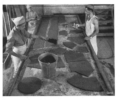
Abb. 11 Die ausgeschnittenen Stücke werden numeriert, angefeuchtet und zu den einzelnen Arbeitsplätzen gebracht
