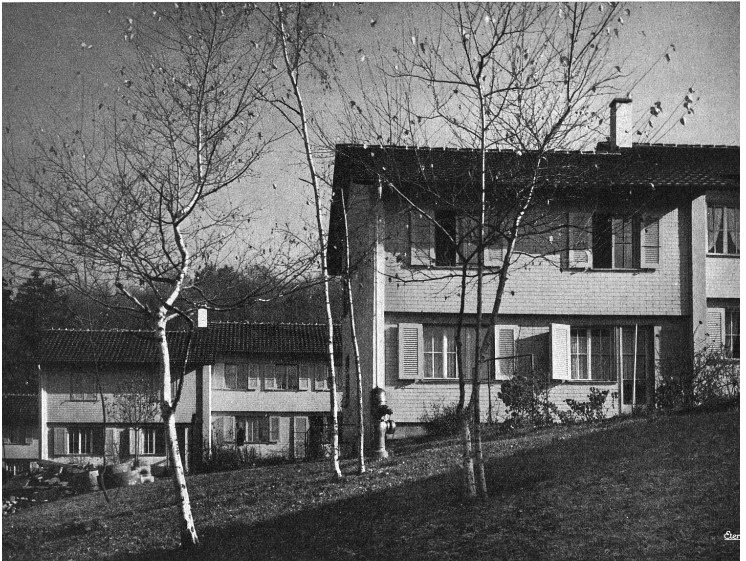
Abb. 1 Südwestansicht der Siedlung «Hohliebe» in Bern-Bümpliz
