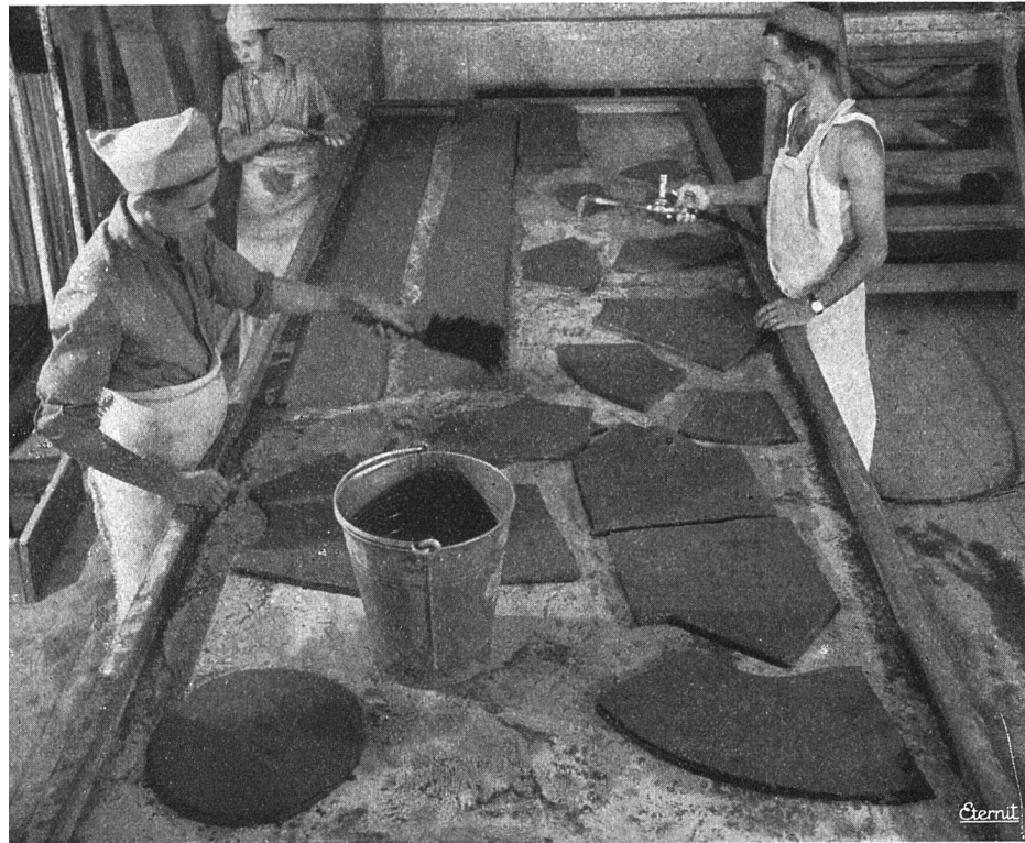
Abb. 11 Die ausgeschnittenen Stücke werden nummeriert, angefeuchtet und zu den einzelnen Arbeitsplätzen gebracht
