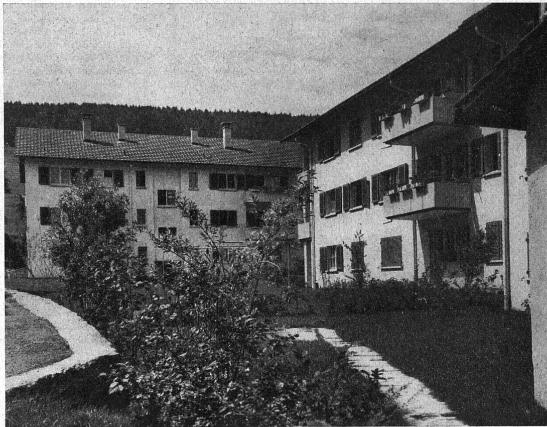
Mehrfamilienhäuser der Mietergenossenschaft «Alpenblick», Horgen
