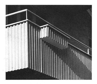
«Aluman», kantig abgebogen, eignet sich speziell für Balkonverkleidung. Merkmale: Rostfrei, temperaturbeständig, unbegrenzte Haltbarkeit.
