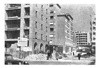
Altstadtsanierung in Marseille – Hier werden die betonierten Häuserfronten mit Marmorplatten verkleidet
