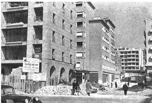
Altstadtanierung in Marseille – Hier werden die betonierten Häuserfronten mit Marmorplatten verkleidet
