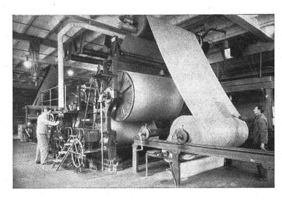
So entsteht Linoleum: Auf dem großen Kalander mit geheizten Walzen wird die Linoleummasse auf die Jute gepreßt. Das fertige Linoleum läuft alsdann über eine Kühltrommel und auf die Rolle
