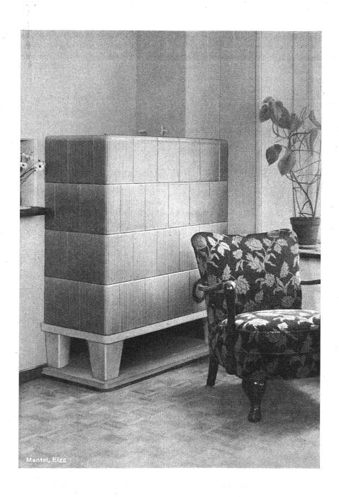
Dadurch entsteht eine Luftumwälzung durch das Ofeninnere, was eine sehr rasche Aufheizung des Raumes bedeutet. Da naturgemäß die Wärmespeicherung gering ist, sind diese Heizeinsätze meist für Dauerbrand eingerichtet.
