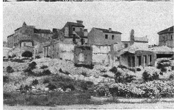
Oben: Im Gebiete von Voinič, wo nach den Partisanenkämpfen kein einziges Haus mehr bewohnbar war, werden einfache Holzhäuser erstellt
