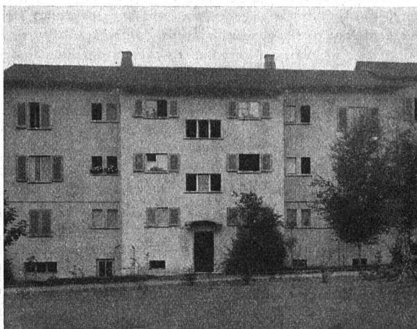
Sternkolonie II. Etappe Nordostansicht an der Spittelerstraße
