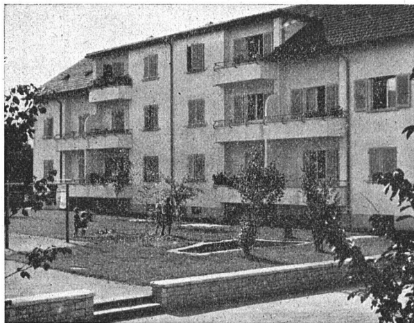
Doppel-Fünffamilienhaus Narzissenweg / hinterer Block
