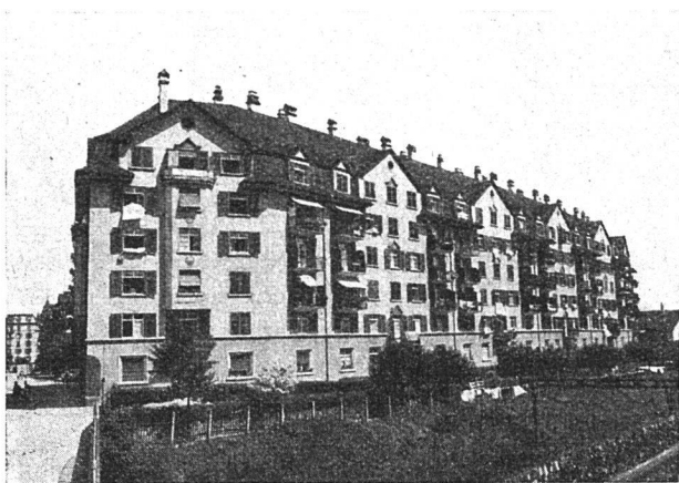
Neuweg gegen den Bahneinschnitt I./II. Etappe
