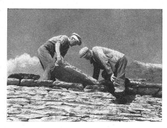
Abb. 5 Beim Verlegen der schweren Dachplatten
