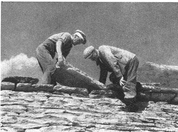
Abb. 5 Beim Verlegen der schweren Dachplatten
