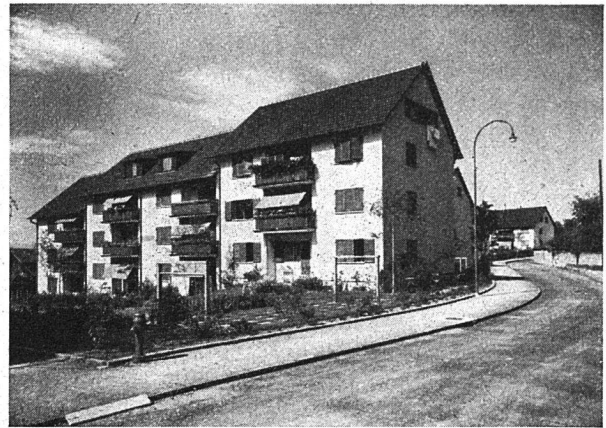
Wylergut, Bern (Mehrfamilienhäuser an der Polygonstrasse, längs der Bahnlinie)
