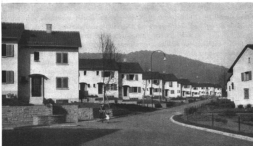
Familienheim-Genossenschaft Zürich 14. Etappe im Döltschi Blick in die Kolonie am Bernhard-Jaeggi- Weg Architekten: Sommerfeld, Zink, Landolt
