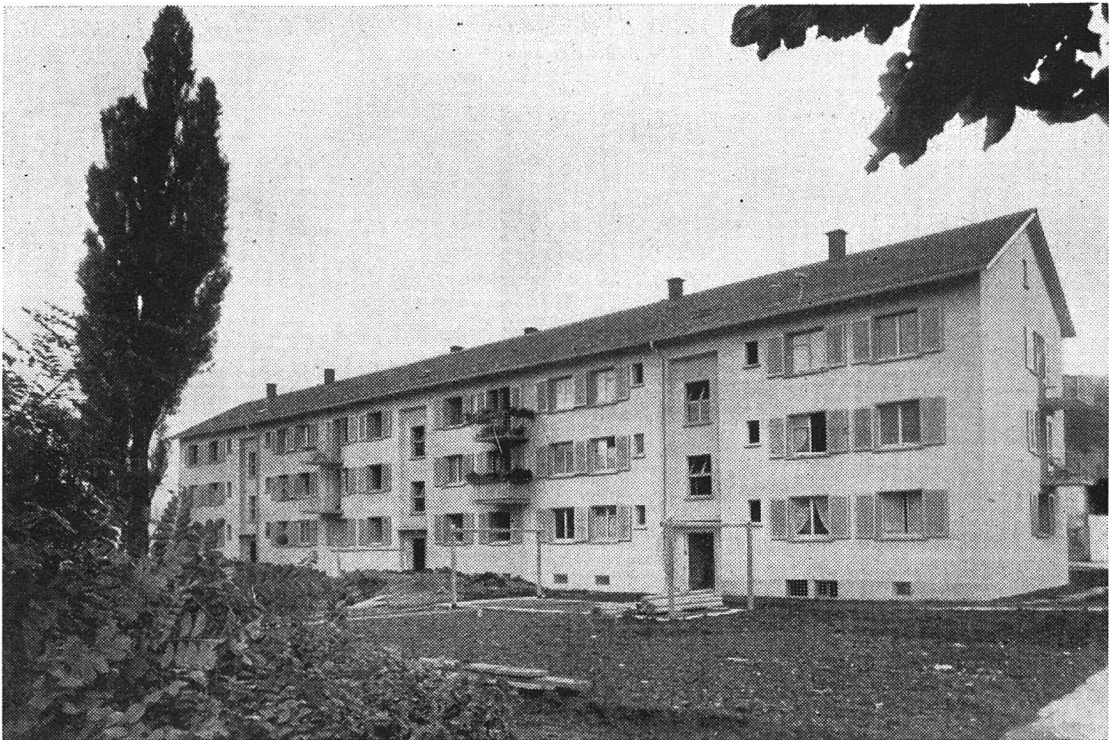
Baugenossenschaft Limmattal, Zürich 9 Mehrfamilienhäuser an der Fellenbergstraße 5. Bauetappe Architekt: W. Hertig
