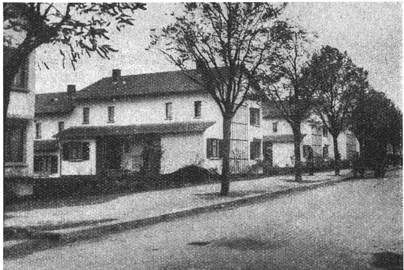
Dreizimmerhaus im Arbestal
