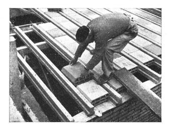
Holzbalkendecken wenn möglich vermieden. Der räumliche Verband zwischen den Mauern, die Schallisolierung zwischen den Stockwerken, die Feuersicherheit, die hygienischen Anforderungen, alle diese Belange werden befriedigender erfüllt durch armierte Betondecken als durch reine Holzdecken oder durch Decken, deren Holztragelemente mit Beton in Verbindung sind.
