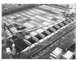
armierung gestattet, mit einer wesentlich geringeren Eisenmenge auszukommen, als dies früher mit gewöhnlichen Betonrundeisen der Fall war. Diese Armierungsart ist nicht zu verwechseln mit den vorgespannten Drähten, wie sie bei den Spannbetonbalken zur Verwendung kommen.
