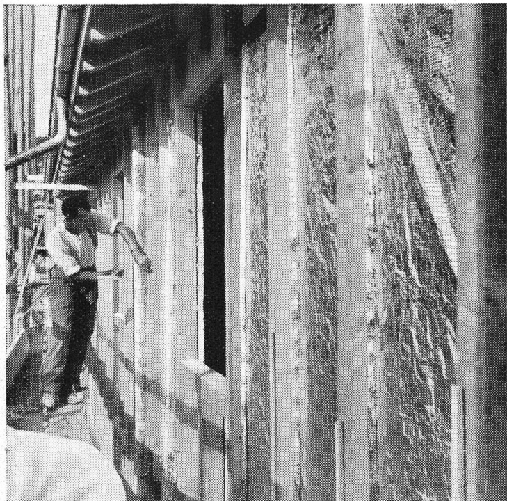
Zwischen die Ständer wird «Alfol» eingespannt.
