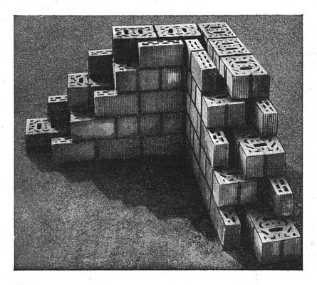
Mauersteine Hohlmauerwerk aus Isoliersteinen, 33 cm stark
