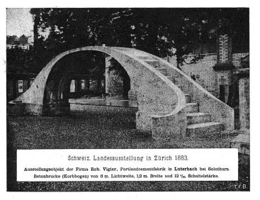
Betonbrücke an der Landesausstellung 1883, die damals als Spitzenleistung der Zement- und Betontechnik gezeigt wurder Der Zusammenbruch erfolgte 16 Stunden nach Belastung mit 32 765 Kilos oder 5,46 Tonnen Eisenbarren per m², infolge Weichen der Widerlager.
