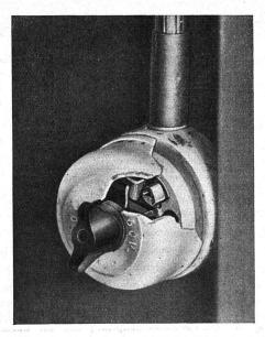
Solche Schalter sind gefährlich und sollten sofort ersetzt werden. Wenn man im Dunkeln den Schalter sucht, kann man leicht mit spannungführenden Teilen in Berührung kommen.
