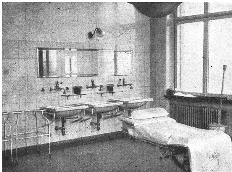
In den Jahreu 1916 bis 1919 arbeitete die Installations- abteilung im Neubau der Kantonalen Frauenklinik in Zürich. — Sanitäre Anlage in einem Operationssaal
