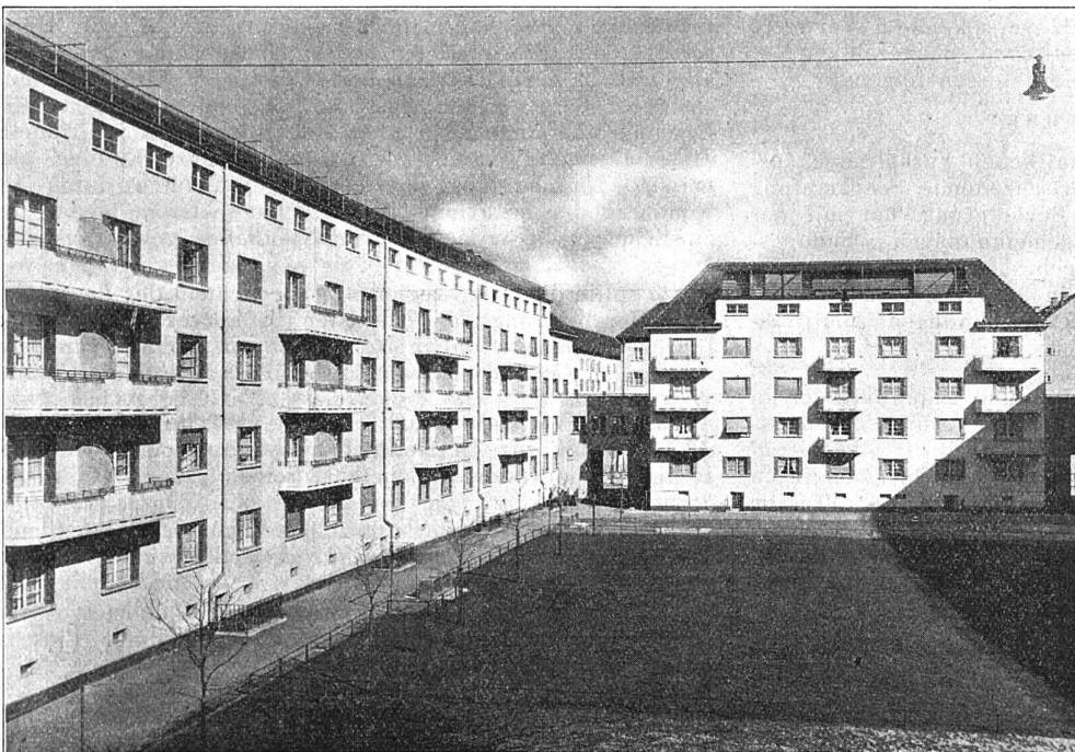
Eisenbahnerhof der Baugenossenschaft des Eidgen. Personals Zürich. Auf dem Bild sind an den Ablaufrohren der Dachtraufen die noch nicht gestrichenen und verputzten Rediffusionsleitungen sichtbar.
