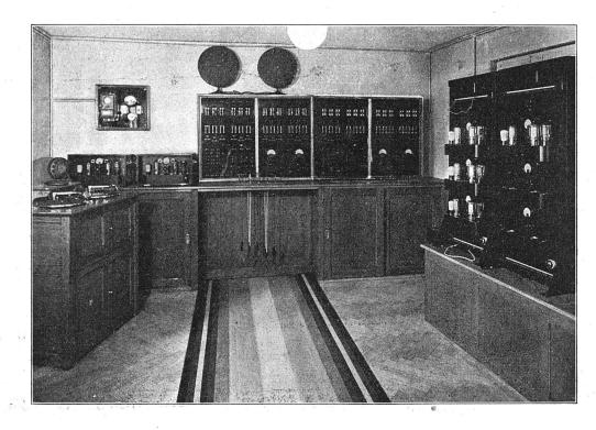
Verstärkerzentrale mit Verteilertableau und Mess-Instrumenten, von wo aus die Verteilleitungen zu den Abonnenten gehen
