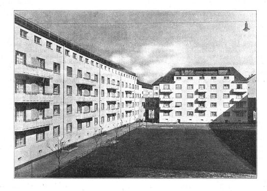
Eisenbahnerhof der Baugenossenschaft des Eidgen. Personals Zürich. Auf dem Bild sind an den Ablaufrohren der Dachtraufen die noch nicht gestrichenen und verputzten Rediffusionleitungen sichtbar.
