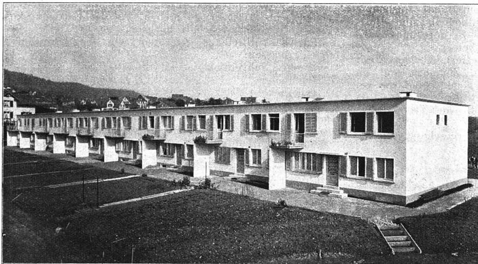
Kreuzreihenhäuser der Heimstättengenossenschaft Winterthur Westansicht des ganzen Blocks
