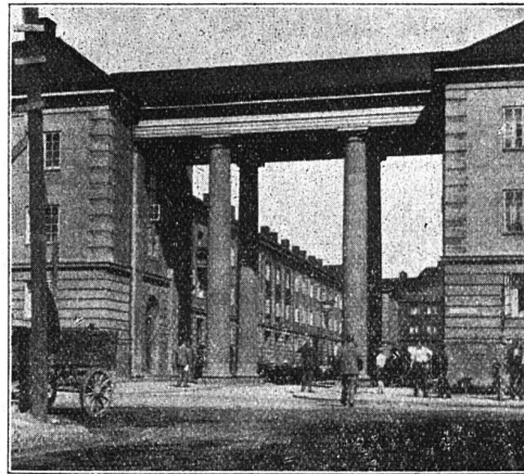
Abb. 2 Oslo, Wohn- kolonie Nor- dre Aasen Pompöser Eingang
