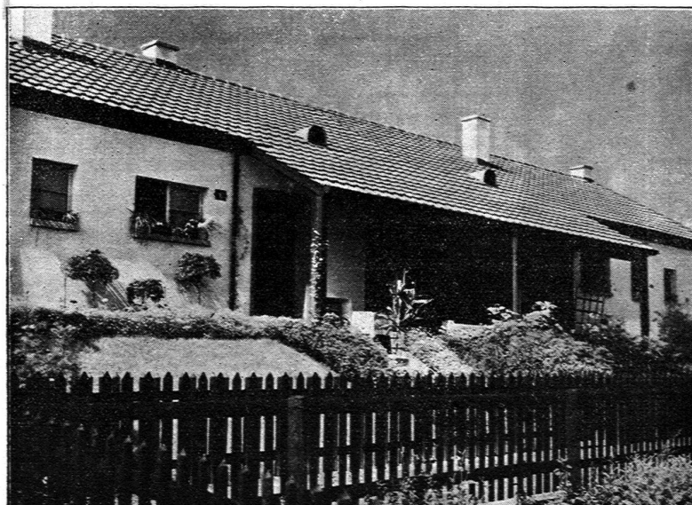
Ansichten aus der dritten Bauphase der Familienheimgenossenschaft Friesenberg, Zürich
