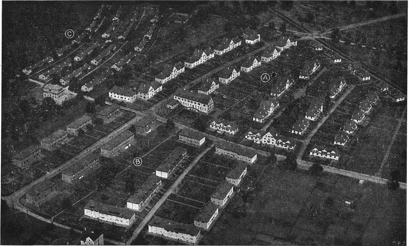
Gesamtansicht der Wohnkolonie am Friesenberg, Zürich
