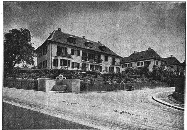
Zum Artikel Baugenossenschaft Vrenelsgärtli, IV. Bauperiode Ansicht Ecke Letzi- und Möhrlistrasse Brunnen von Otto Münch, Bildhauer.
