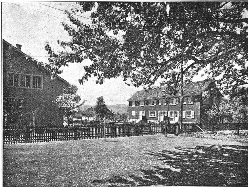
Kolonie der Baugenossenschaft „Allmend“, Zollikon
