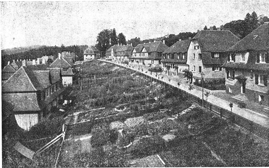
Die Paul Brandstrasse
