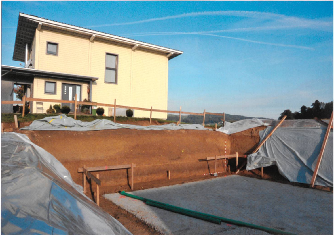
Im Westprofil der Baugrube zeichnet sich der überdeckte Grabhügel mit Grabgrube ab.
