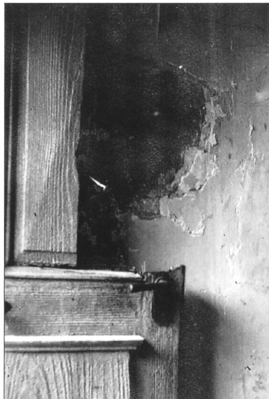
Durchschlag Eingang mit offener Haustüre.
