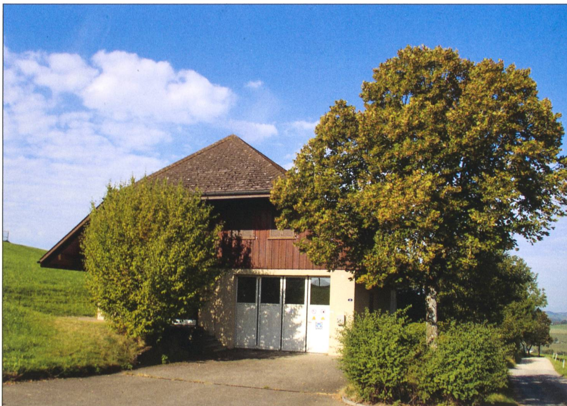
Das Militärgebäude Chanzel auf Grunholz. Es soll allenfalls als Truppenunterkunft ausgebaut werden.
