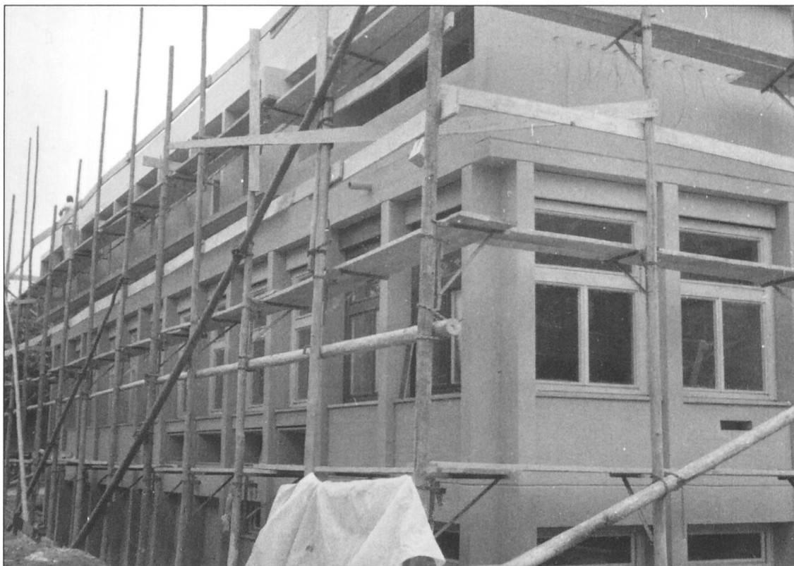
Der Neubau nach Fertigstellung des Rohbaus. Das Holzgerüst entspricht dem damaligen Stand der Technik. Das Bild macht die präzise, scharfkantige Struktur des Sichtbetons deutlich. Gut sichtbar, die auch im Untergeschoss vorhandenen Fassadenpfeiler.
