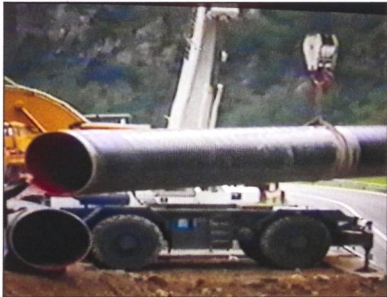
Tonnenschwere Einzelrohre werden ab regionalen Depots hertransportiert.
