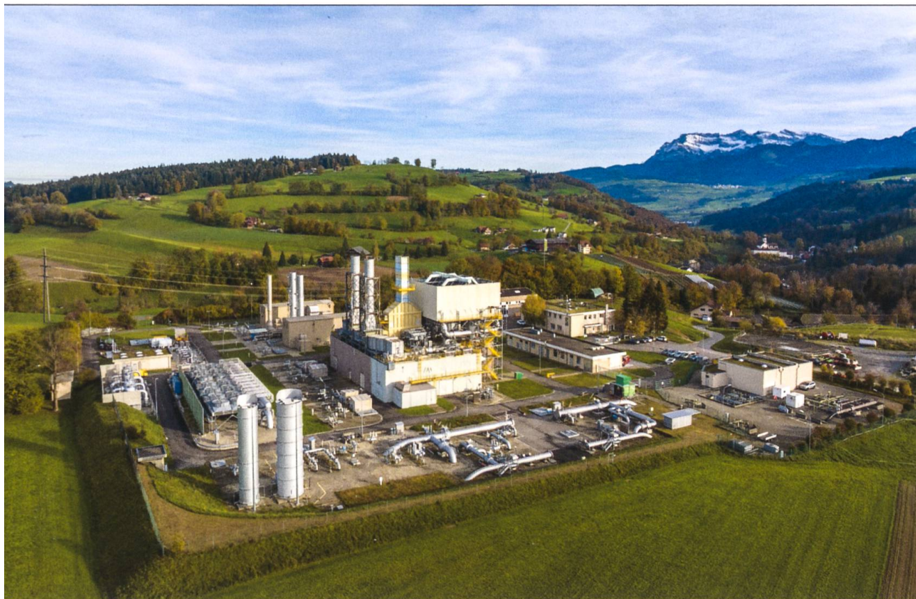
Blick auf die Verdichterstation Horüti, die operative Zentrale der Transitgasleitung.
