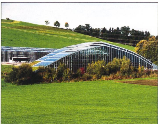
Die Wärmezufuhr aus der Verdichterstation zu den Glashallen beim modernen Tropenhaus Wolhusen wurde aus betrieblichen Gründen eingestellt.
