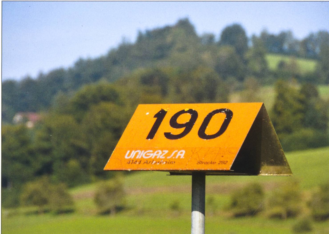
Solche Signaltafeln in der Landschaft markieren die erdverlegten Erdgasleitungen.
