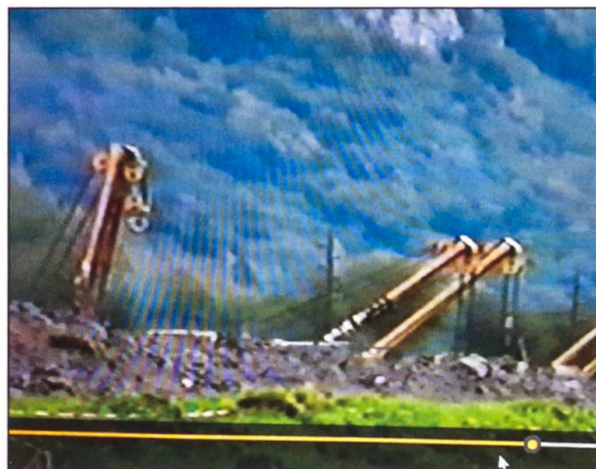
Bagger mit tragstarken Auslegern bei der etappenweisen Leitungsverlegung.
