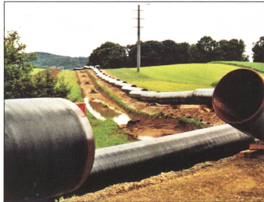
Einzelrohre bereit zum Verschweissen entlang des Leitungsgrabens.
