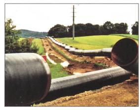
Einzelrohre bereit zum Verschweissen entlang des Leitungsgrabens.
