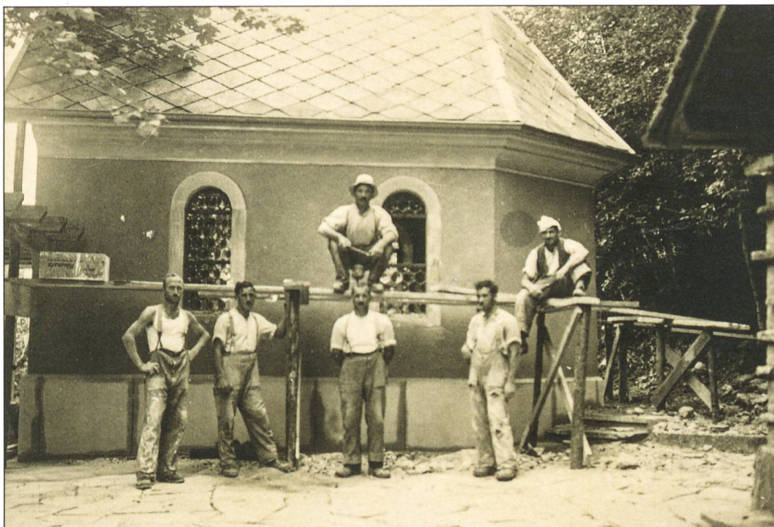
1949 renovierte das Baugeschäft Zettel die Gnadenkapelle Luthern Bad.
