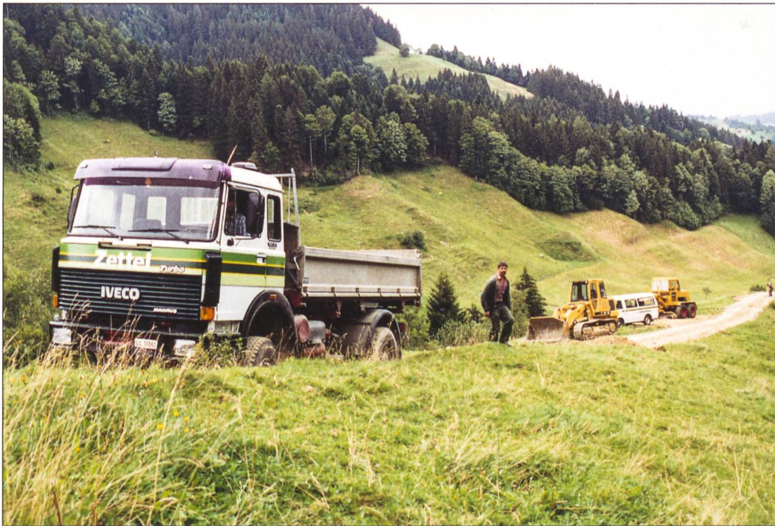
Den IVECO Zweiachs-Allrad Typ 190-32 AH erwarb die Firma F. und H. Zettel AG 1986. Einsatz hier auf der Baustelle Schiessplatz Bodenenzi in Luthern Bad.
