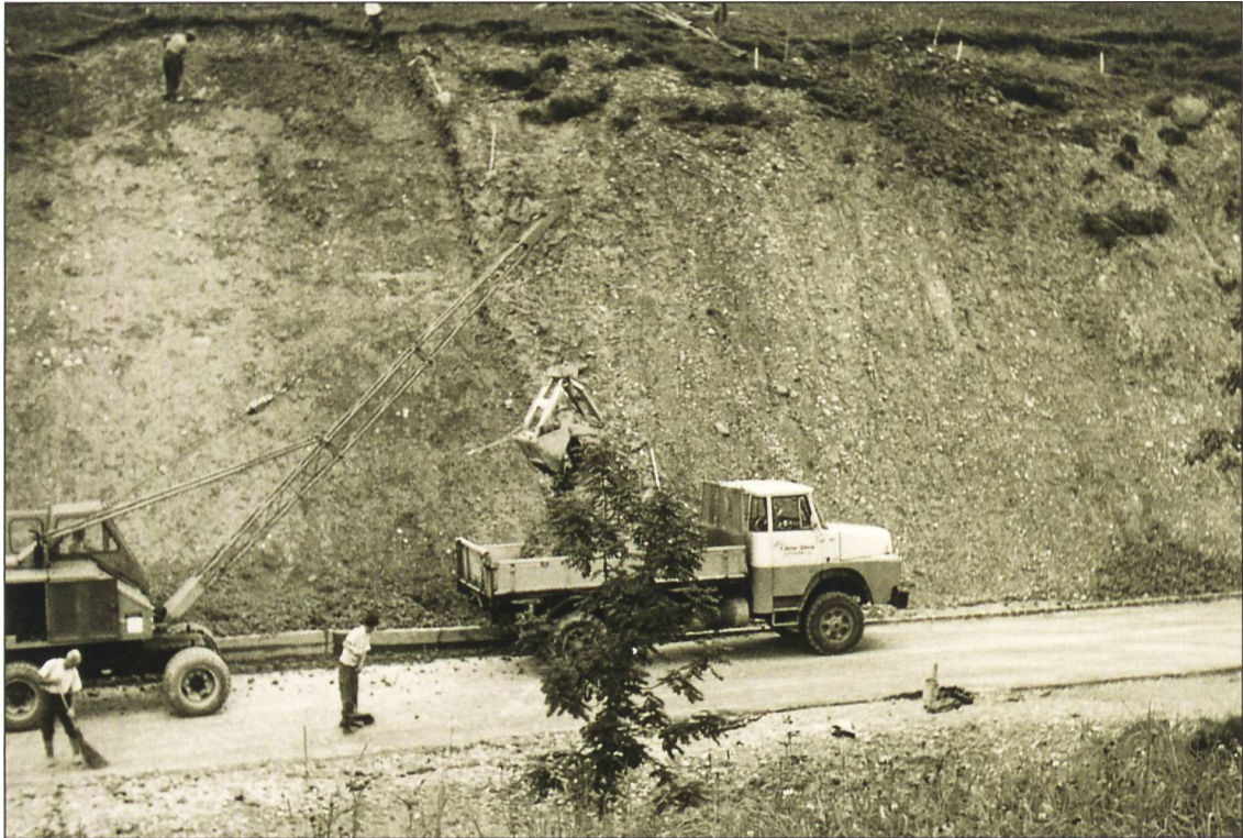
Der neue Henschel HS 16 Hauber wird Anfang der 1960er-Jahre beim Ausbau der Strasse nach Luthern Bad mit einem Traggleitenbagger beladen (Strassenbord zwischen Chrutzi und Luthern Bad wird abgetragen).
