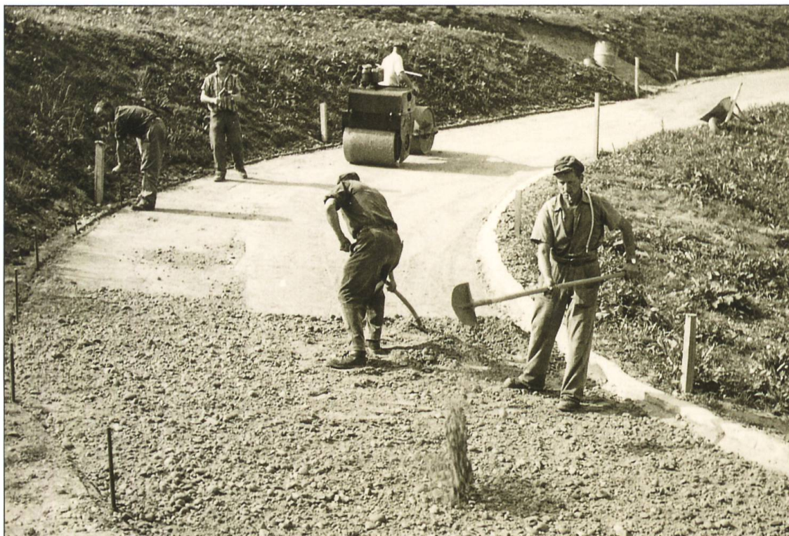
Der Strassenbau im Berggebiet verlangte damals (wie heute) viel Handarbeit, Baustelle Grütstrasse in Hergiswil bei Willisau.
