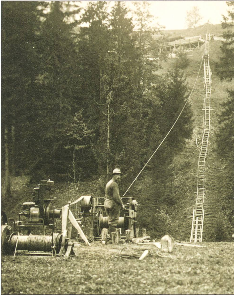
Als die Motorisierung im Bau noch nicht möglich war, wurden höher gelegene Baustellen mit schienegebundenen Seilzügen bedient. Hier als Beispiel der Einsatz beim Bau des Wasserreservoirs der Wasserversorgung in Luthern Bad.
