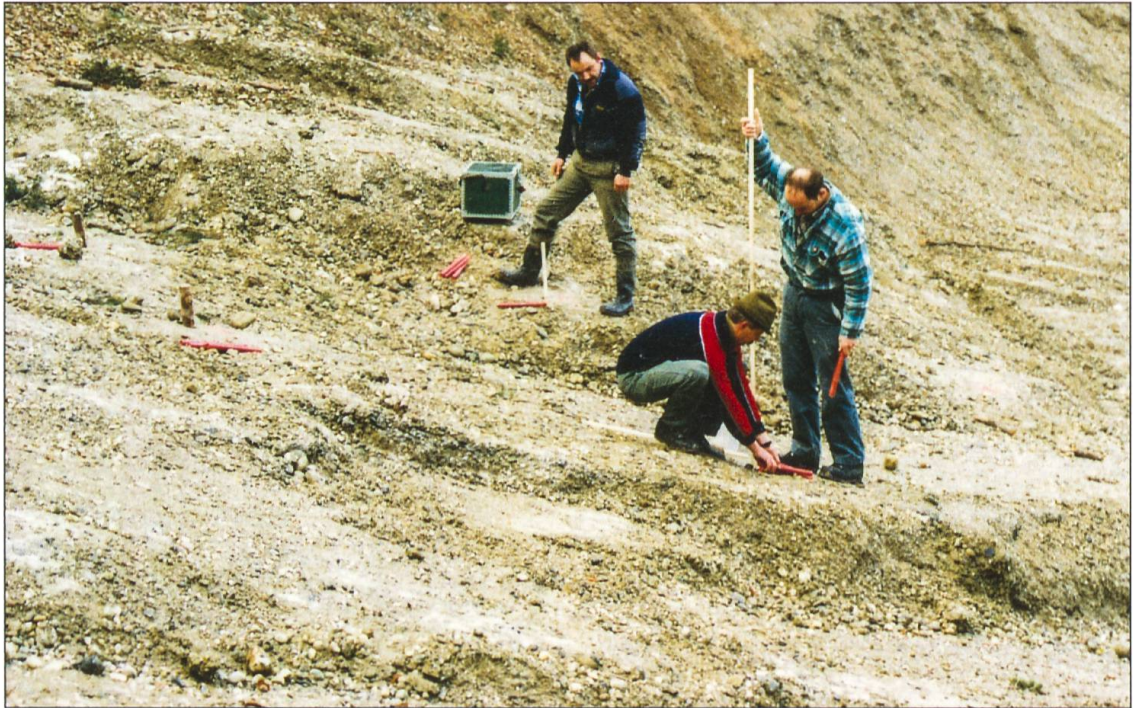
Der heutige Inhaber der Zettel AG, Hansjörg Zettel (rechts), ist berechtigt, Sprengarbeiten auszuführen, hier in der ehemaligen Kiesgrube «Chasern» in Altbüron.
