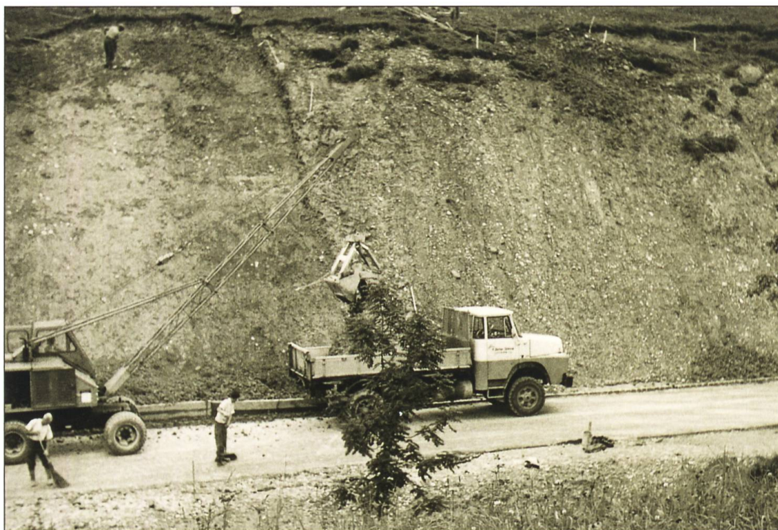
Der neue Henschel HS 16 Hauber wird Anfang der 1960er-Jahre beim Ausbau der Strasse nach Luthern Bad mit einem Tragleinenbagger beladen (Strassenbord zwischen Chrutzi und Luthern Bad wird abgetragen).
