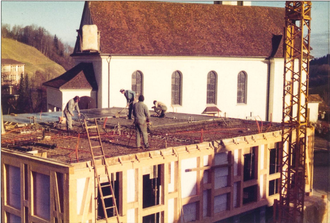
1973/74, Bau des «Haus zur Wölfen» in Luthern, heute Oberdorf 8. Das ehemalige Schulhaus wird mittlerweile als Gemeindehaus genutzt.
