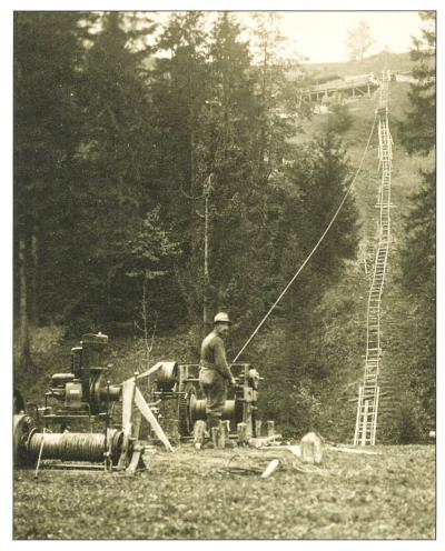
Als die Motorisierung im Bau noch nicht möglich war, wurden höher gelegene Baustellen mit schienengebundenen Seilzügen bedient. Hier als Beispiel der Einsatz beim Bau des Wasserreservoirs der Wasserversorgung in Luthern Bad.
