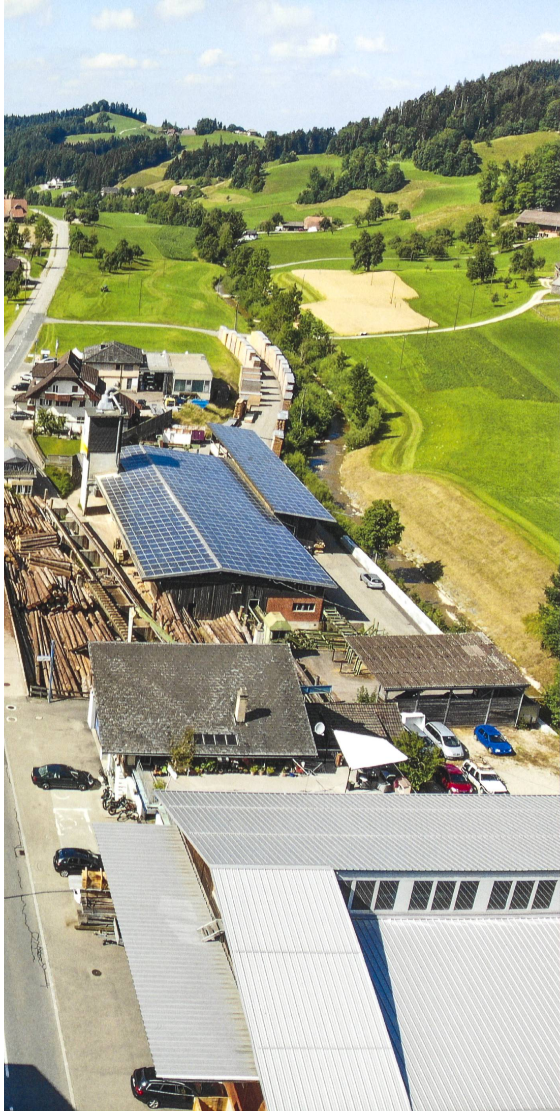
Die 3500 Solarmodule auf den Dächern der Sägewerke Christen AG produzieren grössere Strommengen als vom Unternehmen selbst benötigt. Foto Sägewerke Christen AG
