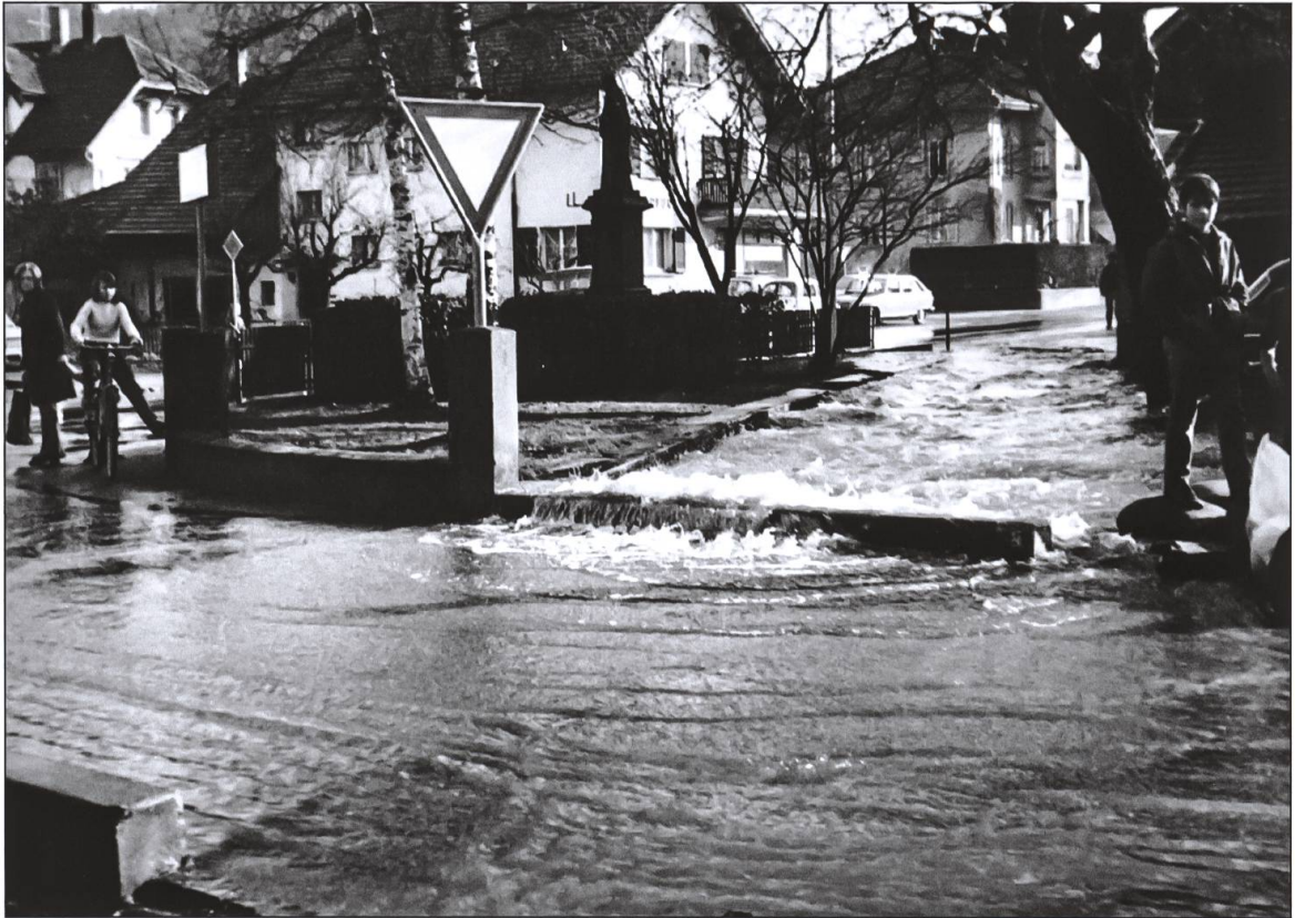
Hochwasser 23. November 1972, Brücke Werkstrasse.
