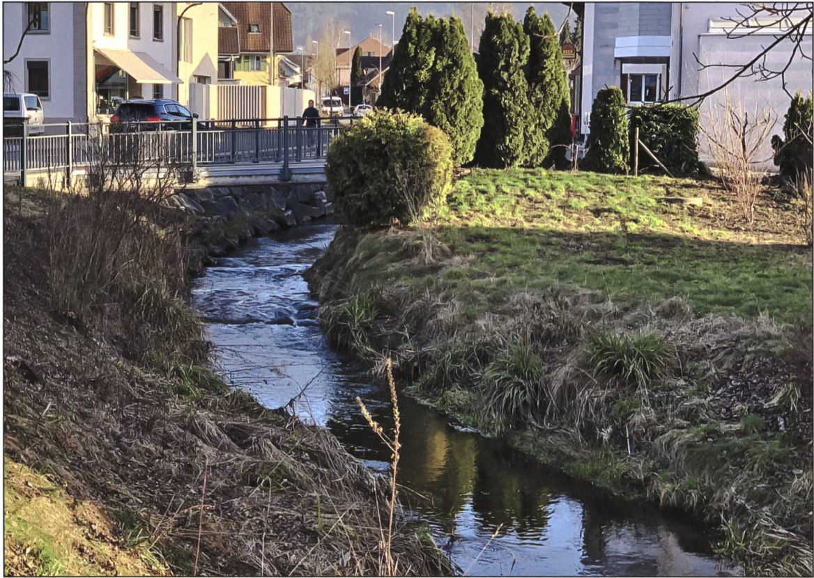
Hürnbach bei der Post, Ausbau 1993.
