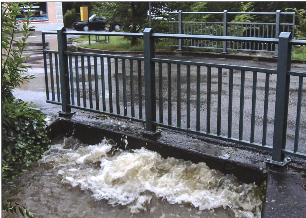
Hürnbach 8. August 2007, Brücke Kanzleiweg.
