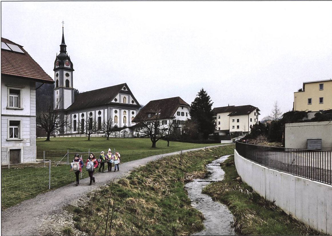
Hürnbach Dorf, Ausbau 2019.
