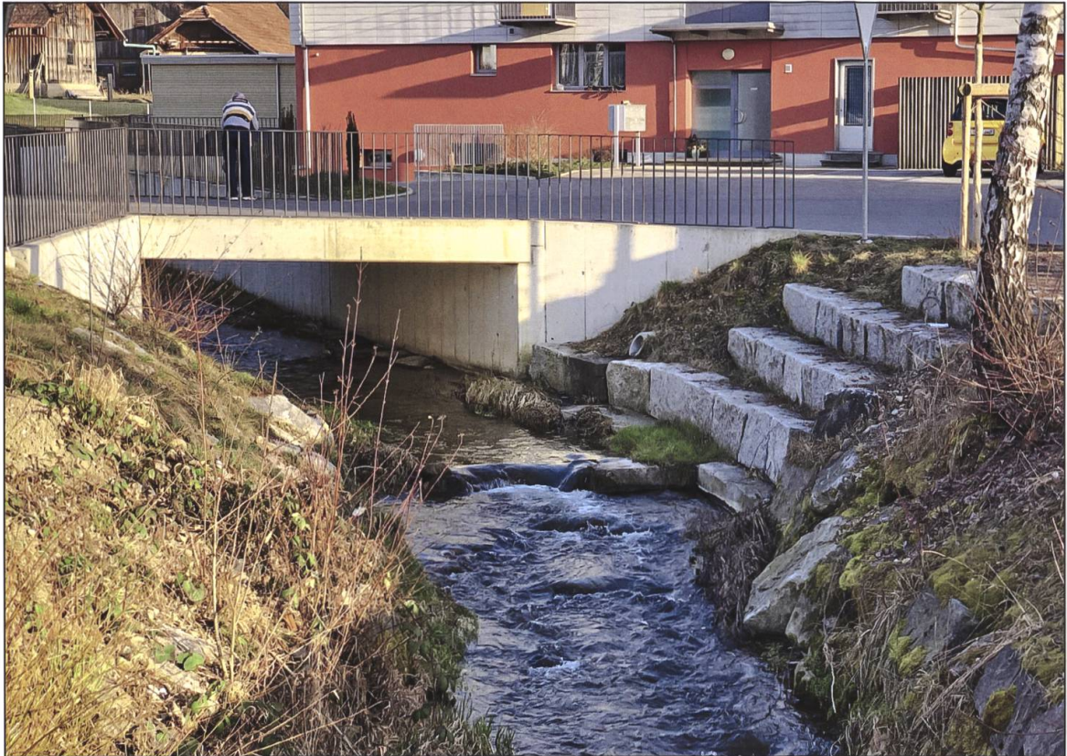
Hürnbach Denner, Kanzleiweg, Ausbau 2019.
