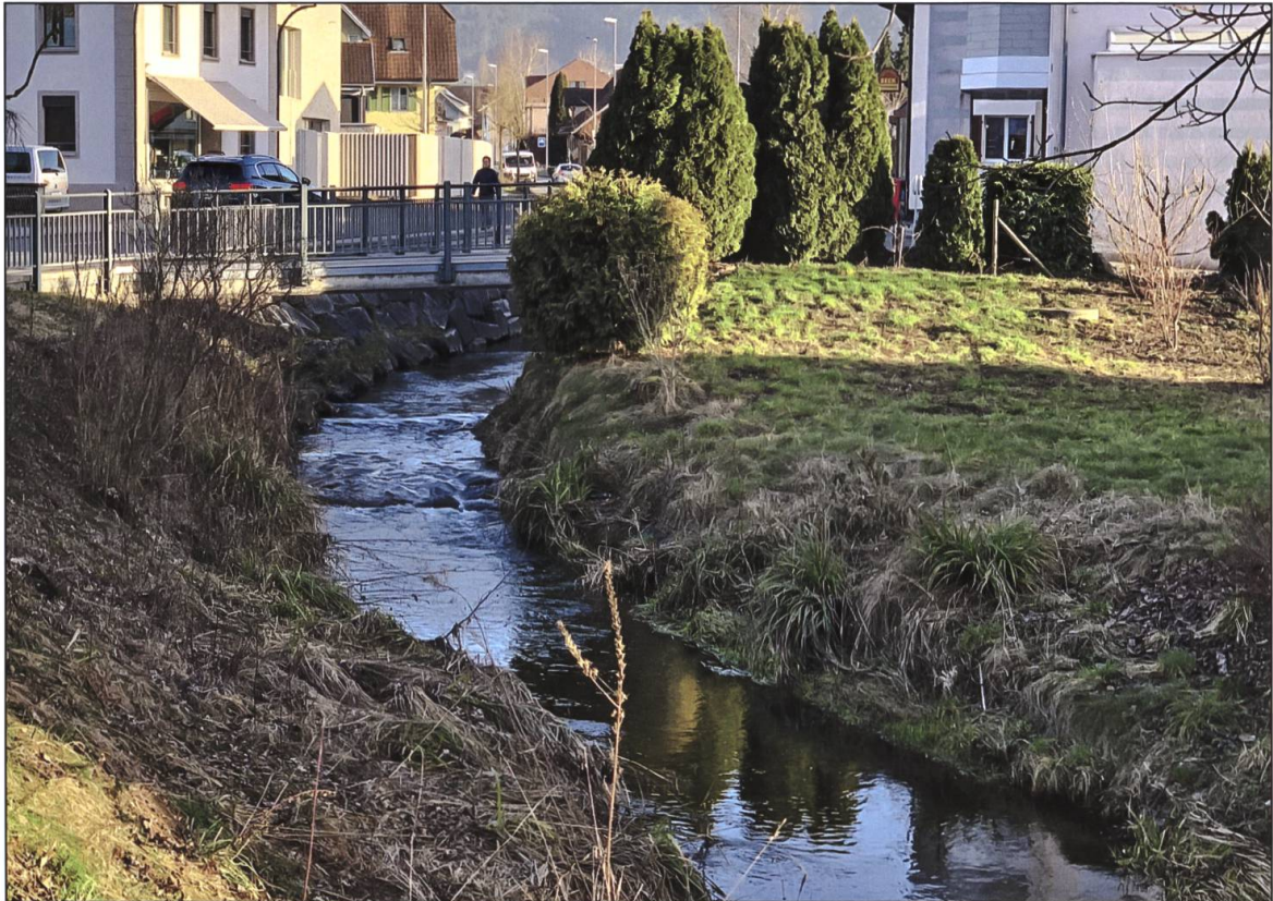
Hürnbach bei der Post, Ausbau 1993.
