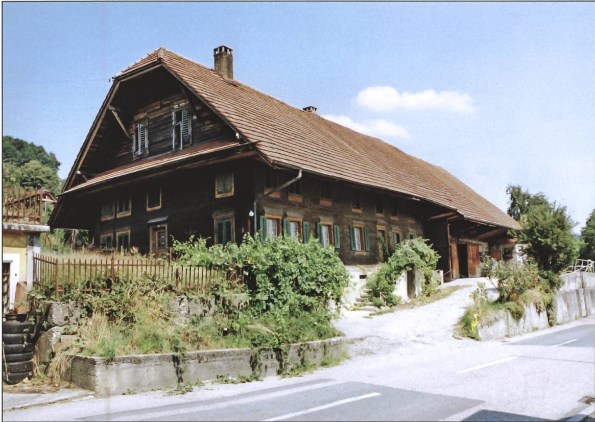
Liegenschaft «Chrämerhus». Wohnhaus und Scheune wurden 2020 abgebrochen. Hier stehen heute drei Mehrfamilienhäuser mit Eigentumswohnungen. Foto Florian Blum
