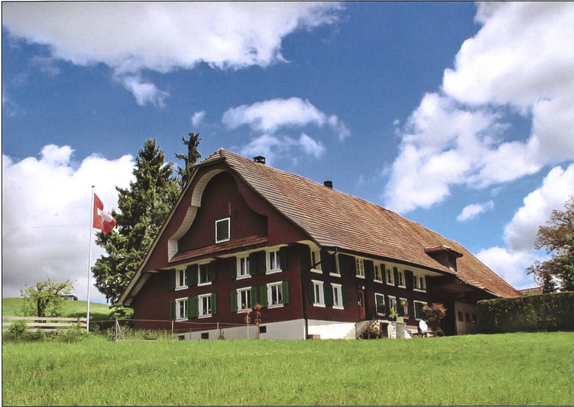
Liegenschaft «Martisrüti». Das Wohnhaus wird privat genutzt. Das dazugehörige Land liegt ausserhalb der Bauzone.
