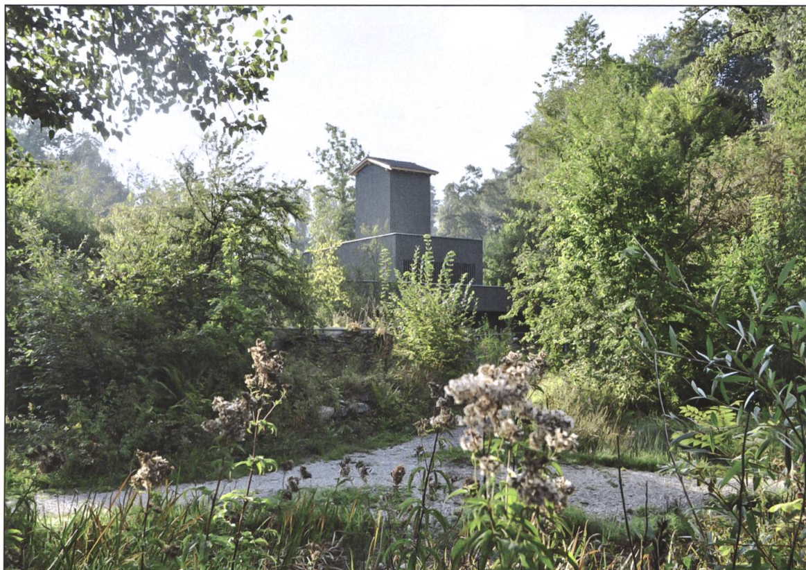
Das neue Schul- und Ausstellungsgebäude ist beinahe fertig gestellt.
