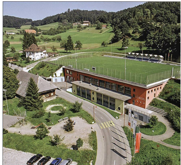
Mehrzweckanlage Hiltbrunnen mit Feuerwehrmagazin und Sportplatz.
