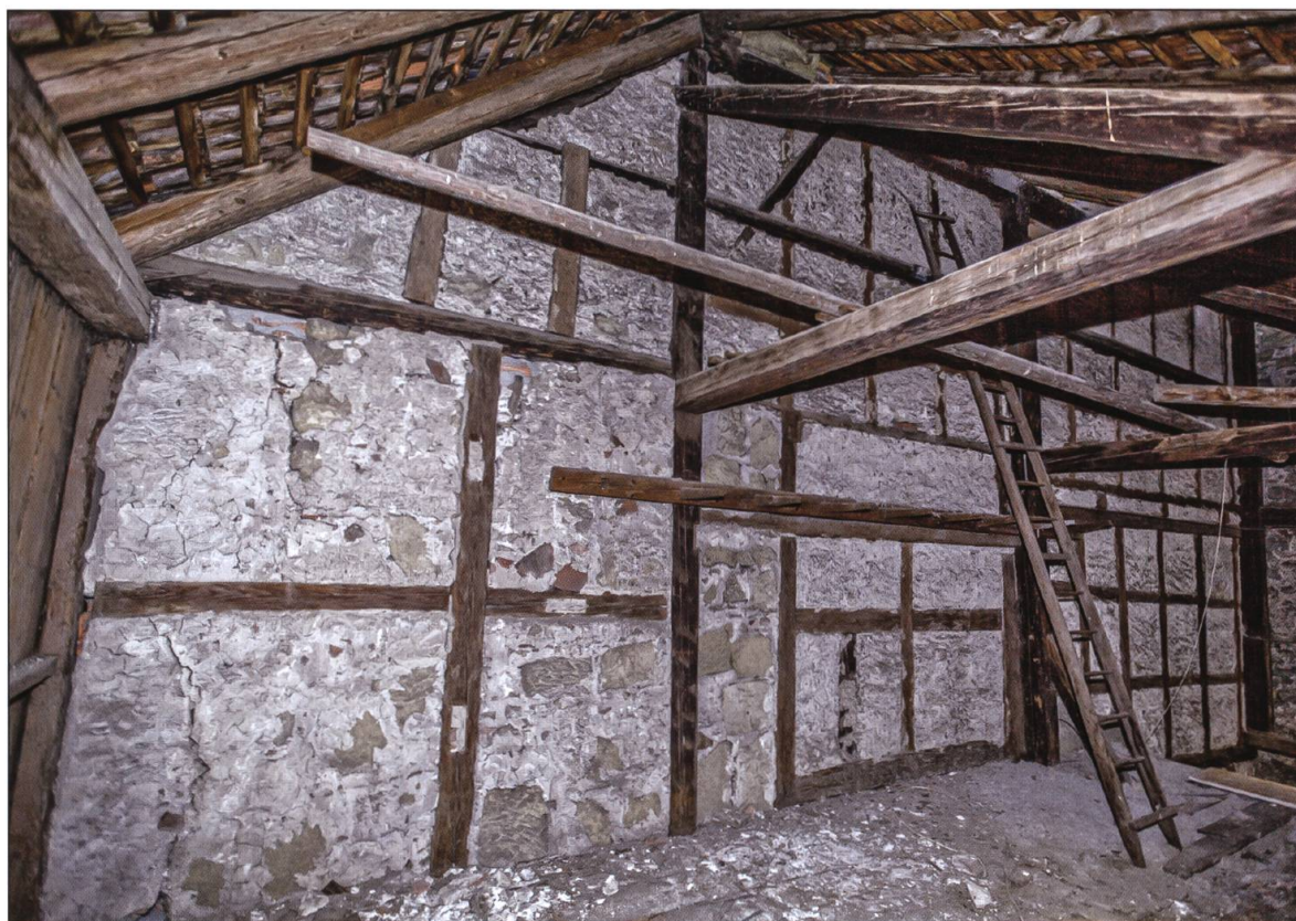
Abb. 3 Südansicht der nachträglich in mehreren Phasen entstandenen Riegelwand im Dachstuhl zwischen dem Wohn- und dem Ökonomietrakt (18./19. Jahrhundert). Die darin eingelassenen, rauchschwarzen Ständer und Verstreibungen gehören zur Firstständerkonstruktion von 1462/63.
