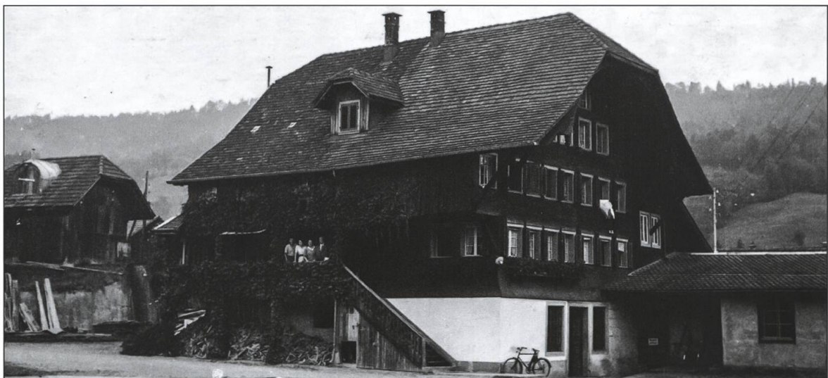
Alte Mühle in Malters: Dieser Bau von 1649 war gewissermassen das Fundament der nachfolgenden Erweiterung und Aufbau der industriellen Getreideverarbeitung von 1910. Die Wasserzufuhr wurde durch einen zwei Kilometer langen Kanal ab dem Weiler Ettisbühl von der kleinen Emme, die ihr Quellgebiet am Briener Rothorn hat, bewerkstelligt.
