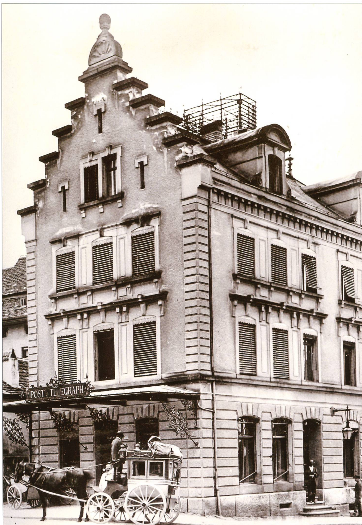
1880, das von Fritz Senn erbaute Postgebäude; im Hintergrund das Metallgerüst auf dem Turmdach, das die Telegrafentelegraphenleitungen aus der Schweiz sammelte. Foto Emil Scherrer
