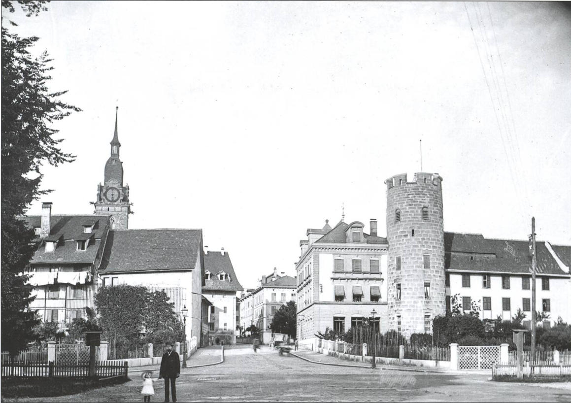
1885, der Turm mitten in der Umbauphase.
