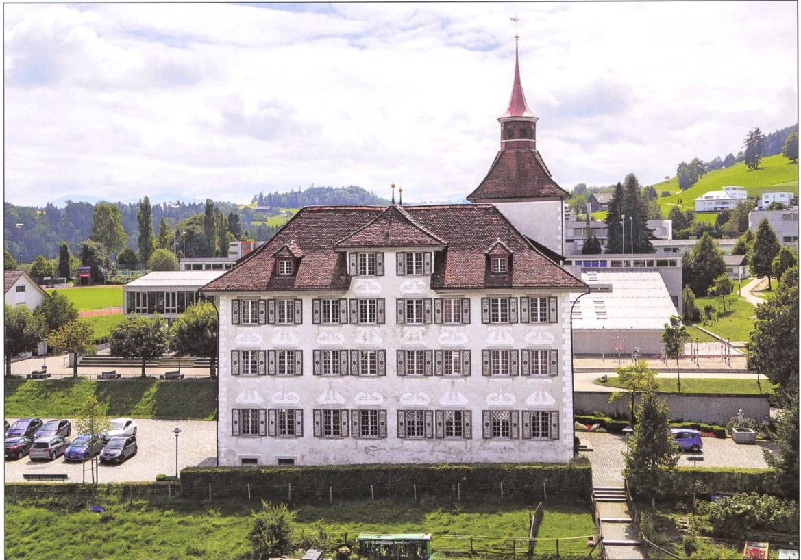
Willisau, Landvogteischloss, erbaut 1690 bis 1695, der einzige feste Sitz eines Landvogts im Luzernbiet. Schlichter querrrechteckiger Bau, symmetrisch, mit drei Geschossen, die Fenster paarweise angeordnet, die beiden Längsfronten durch ein Zwerchhaus mit zwei Fenstern erhöht; damit erhält das Walmdach einen Kreuzfirst. – Nach dem Bauernkrieg von 1653 residiert der Landvogt noch unten im Städtchen. Der Bau von 1695 auf der Anhöhe zeigt: Architektur kann sprechen.
