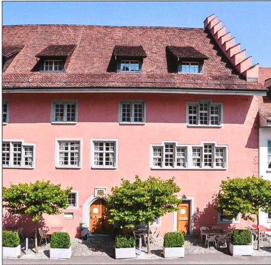
Beromünster, Amtshaus erbaut 1536 als Sitz des Verwalters des Chorherrenstifts.
