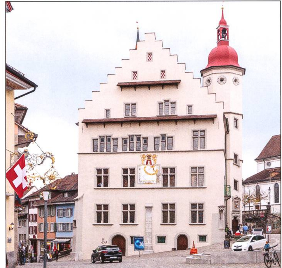
Sursee, Rathaus erbaut 1539 bis 1546 als Markthaus mit Sust, Ankenwaage, Tuchlaube.
