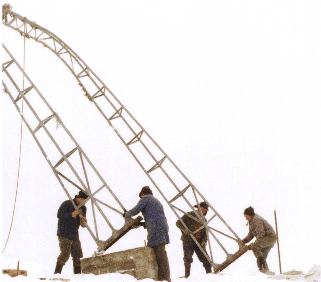
Aufrichten der Gittermasten. Sammlung Skilifgenossenschaft Hübeli
