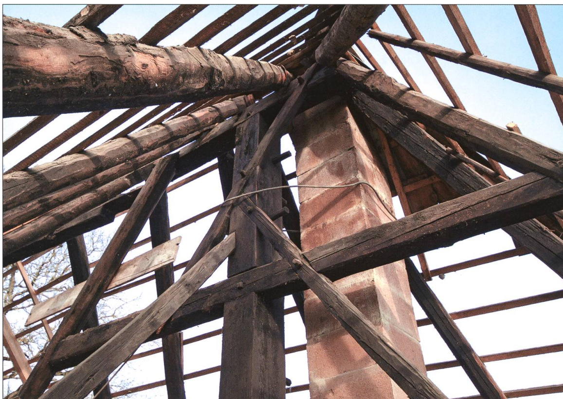
Firstständer aus erster Bauphase, November 2019.
