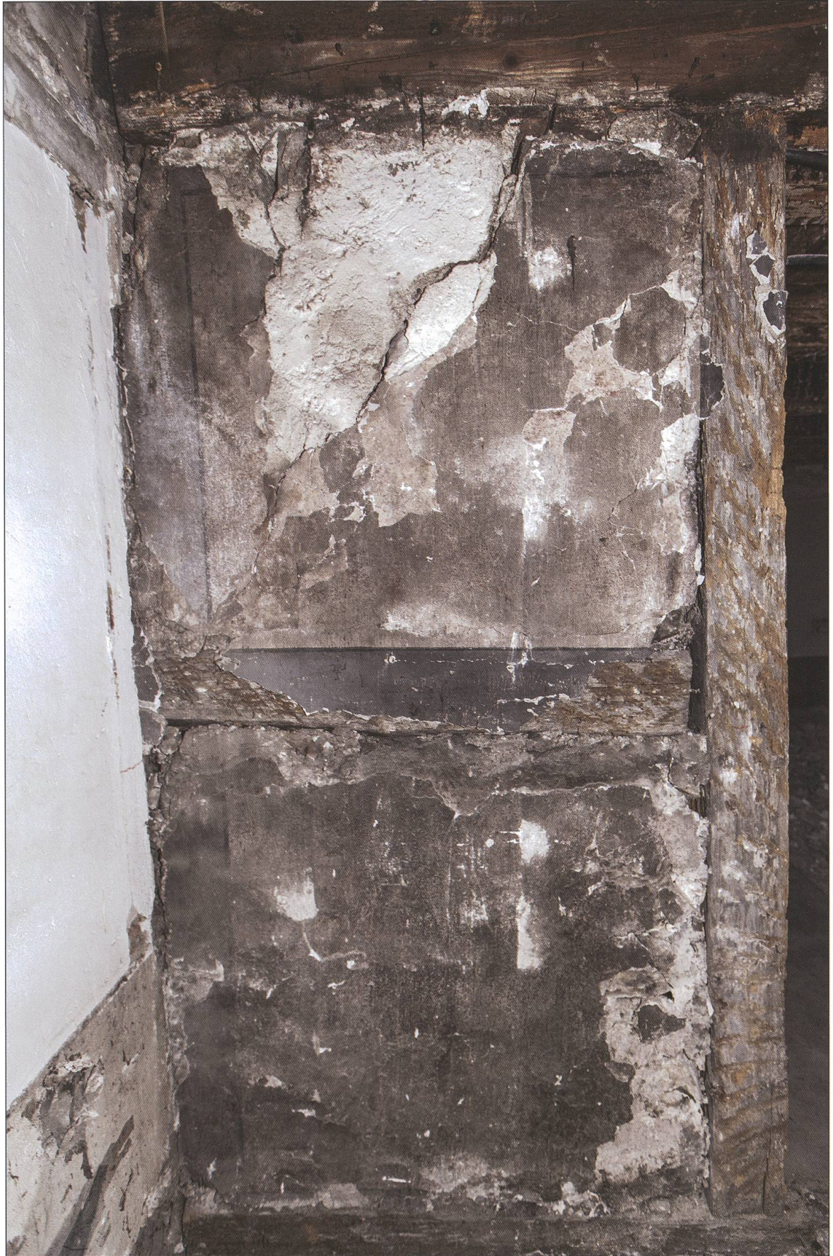
Graue Bandfassung des 17. Jahrhunderts auf der Binnenwand im 1. Obergeschoss.
